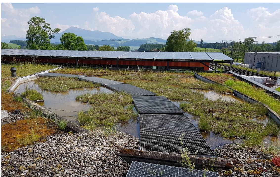
Figure 32 : Mare GemH aménagée avec un bac et de nombreux îlots recouverts de végétation, 10 juin 2021
