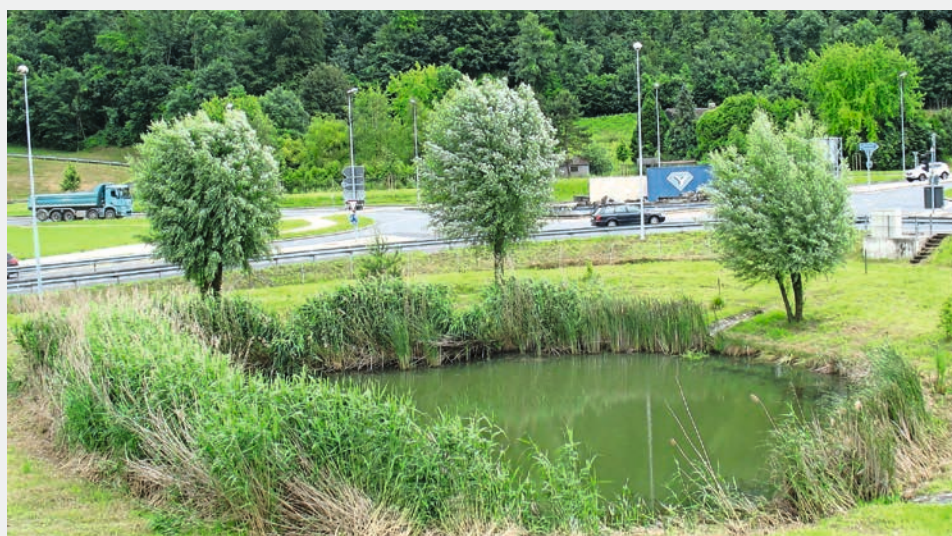
Fig. 2 Ce petit étang urbain de 400 m 2 peut stocker 1000 m 3 d'eau, et même temporairement beaucoup plus grâce à une grande zone inondable. Ce bassin de rétention reçoit les eaux de ruissellement provenant du réseau routier au Sud d'Yverdon (VD) et contribue à la régulation du flux hydrique en zone urbaine.
