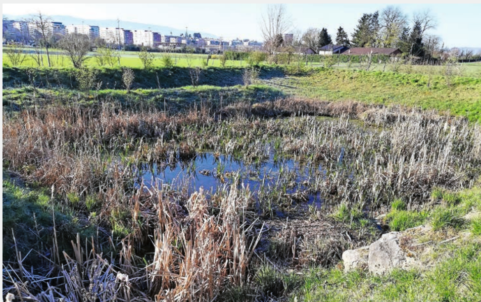
Fig. 3 Le fort recouvrement par la végétation émergente (ici des massettes, Typha latifolia ) permet à l'étang de la Maille (Meyrin, GE; 170 m 2 ) de présenter un fort potentiel en phyto-épuration des eaux.
