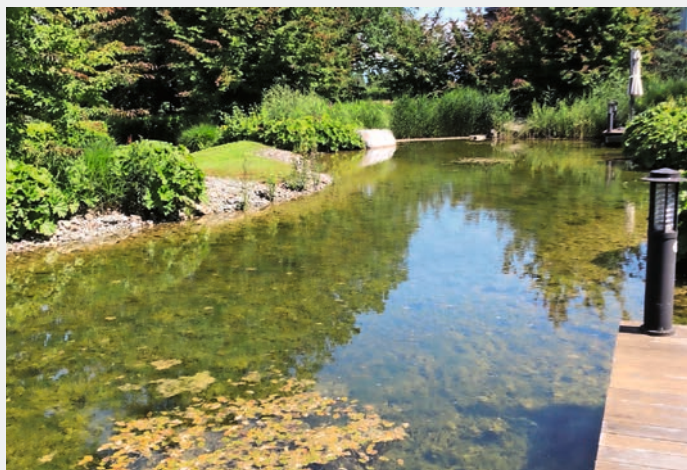
Fig. 9 Cette surface en eau, bien que modeste (400 m 2 ), est suffisante pour ce cas concret, où le volume de la mare parvient à capter la totalité de l'eau de ruissellement provenant du bâtiment voisin. Etang de la Pallanterie (GE).
