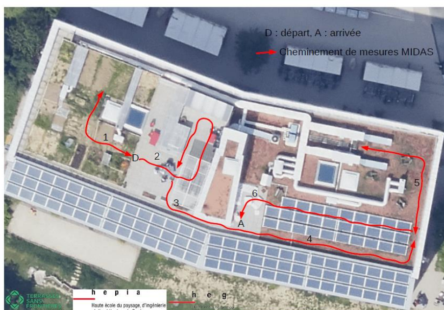
Figure 2: Trajet à suivre pour les mesures sur le toit de Soubeyran.
